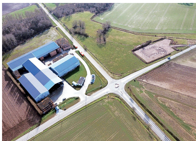
L'objectif de STG est une autonomie totale en 2030 à travers la combinaison du photovoltaïque et de l'éolien.
